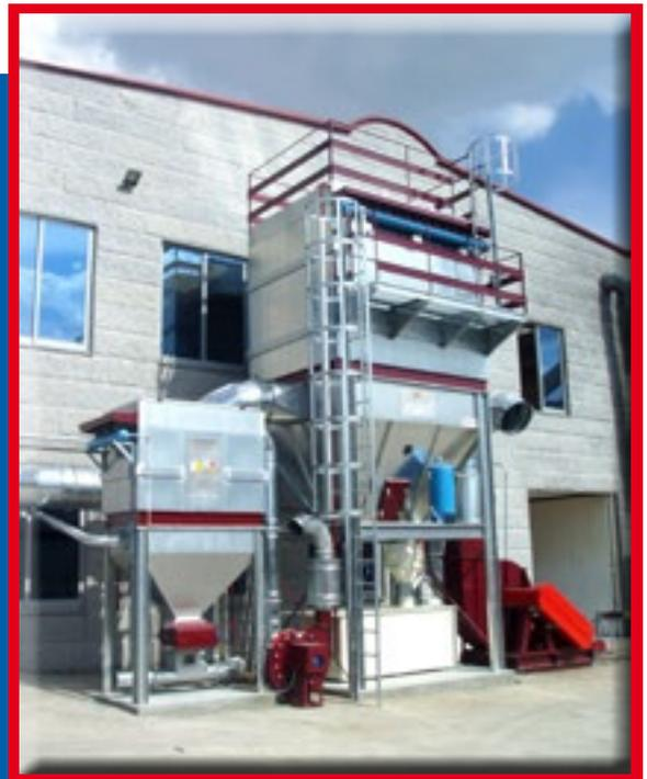
**FILTROS CON LIMPIEZA DE MANGAS POR AIRE COMPRIMIDO Y DESCARGA DE RESIDUO A RECIPIENTE METÁLICO**
