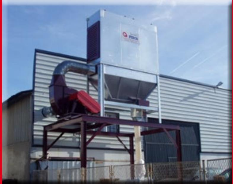
**FILTROS CON LIMPIEZA DE MANGAS POR VIBRACIÓN
