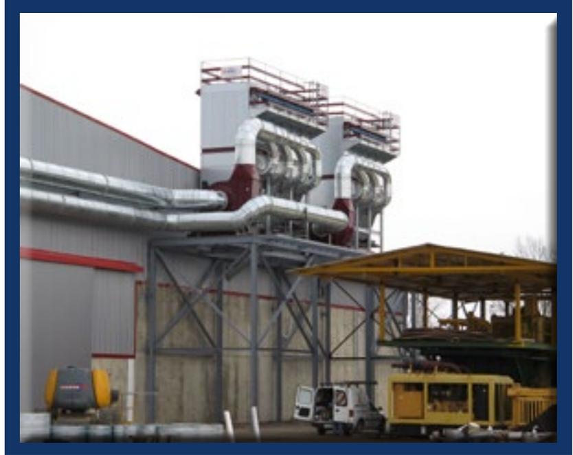
**FILTROS CON LIMPIEZA DE MANGAS POR AIRE COMPRESIVO Y DESCARGA A CONTENEDOR O BIG-BAG**
